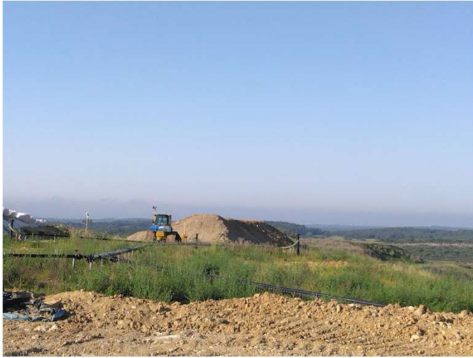
Mai 2022 – Constitution des stocks d'argile et modelage des matériaux sur le dôme
