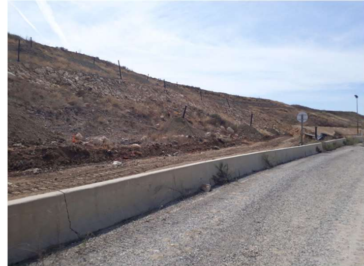
Septembre 2022 : modelage et reprofilage des talus
