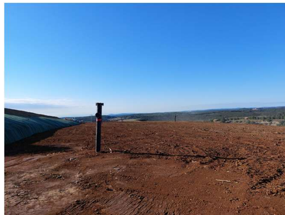
Janvier 2023 : dépose réseau biogaz en partie sommitale et apport de terre végétale
