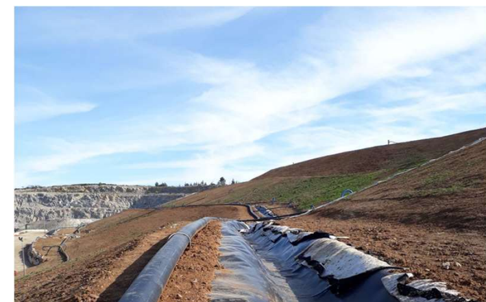
Mars 2023 : fin des travaux
