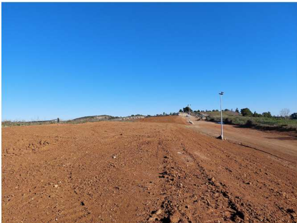
Janvier 2023 : dépose réseau biogaz en partie sommitale et apport de terre végétale
